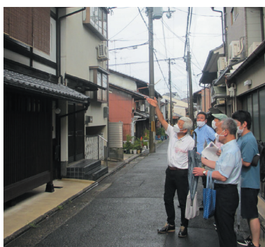
〈現場見学会〉 京町家・工事現場
