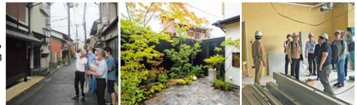
〈現場見学会〉 京町家・工事現場
